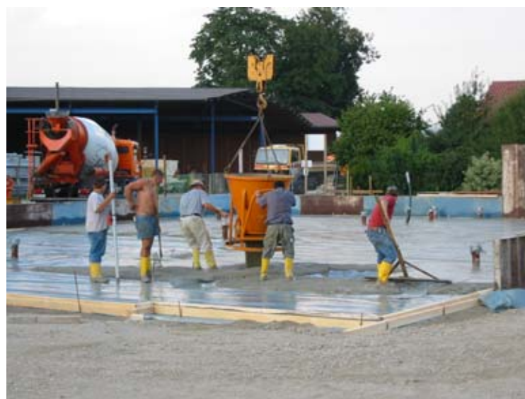
Betonieren der Fundamentplatte am 03. September 2002
