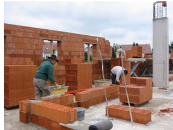
Hier entsteht die Mauer zwischen Fahrzeughalle und Schlauchpflgehalle
