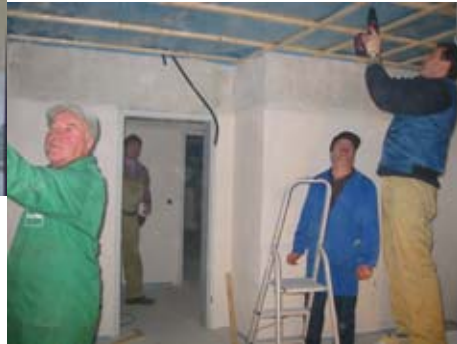
Montage der Unterkonstruktion für Holz- und Rigipsdecken im Jan. 2004
