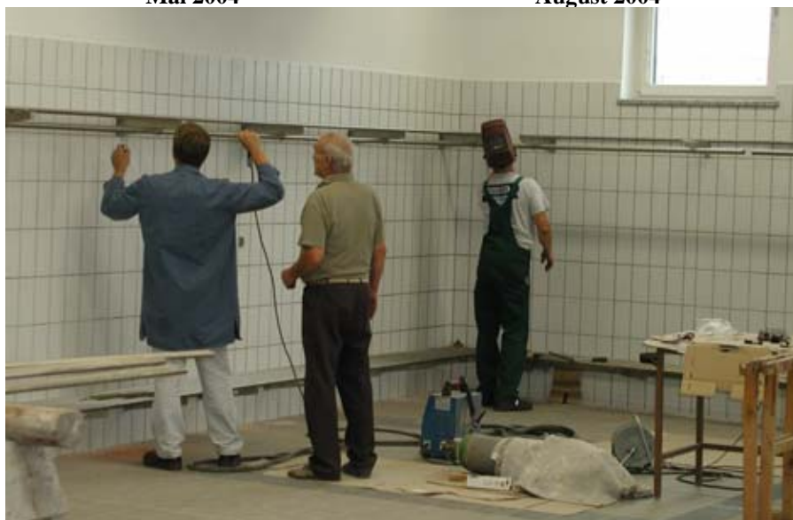
Montage der Helm und Stiefelablage August 2004
