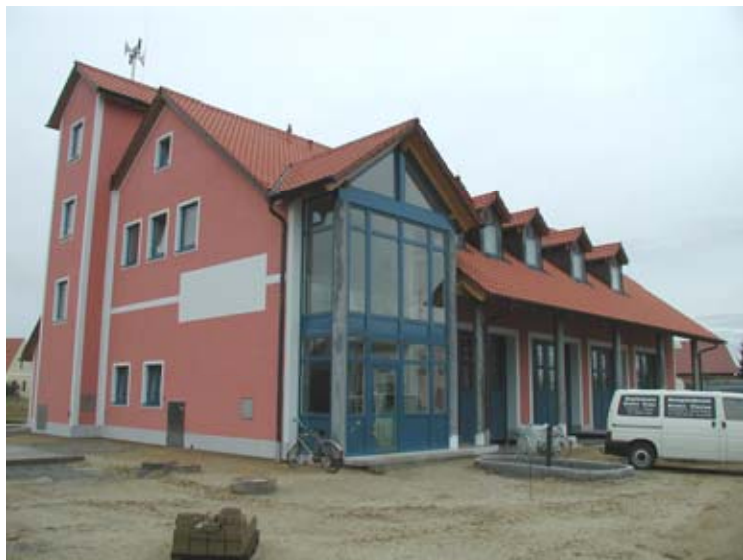
Fertigstellung der Malerarbeiten an der Aussenfassade - September 2004
