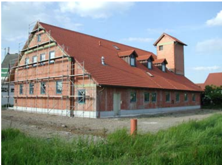
Gerätehaus eingerüstet für die Verputzarbeiten / Süd-West-Ansicht
