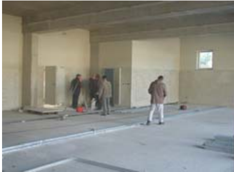
Setzen der Entwässerungsrinnen im November 2003
