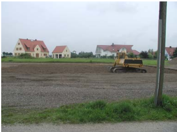
Beginn der Bauarbeiten mit Abtragung der Humusschicht im August 2002
