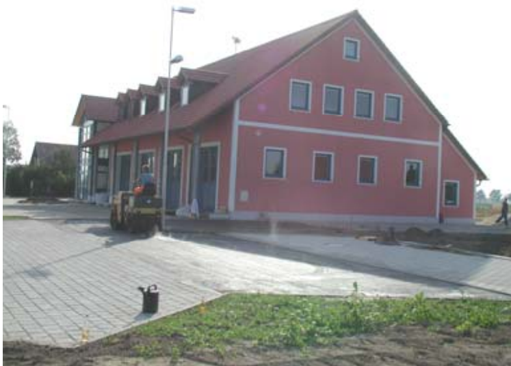
Teearbeiten der Zufahrt für die Parkplätze - September 2004
