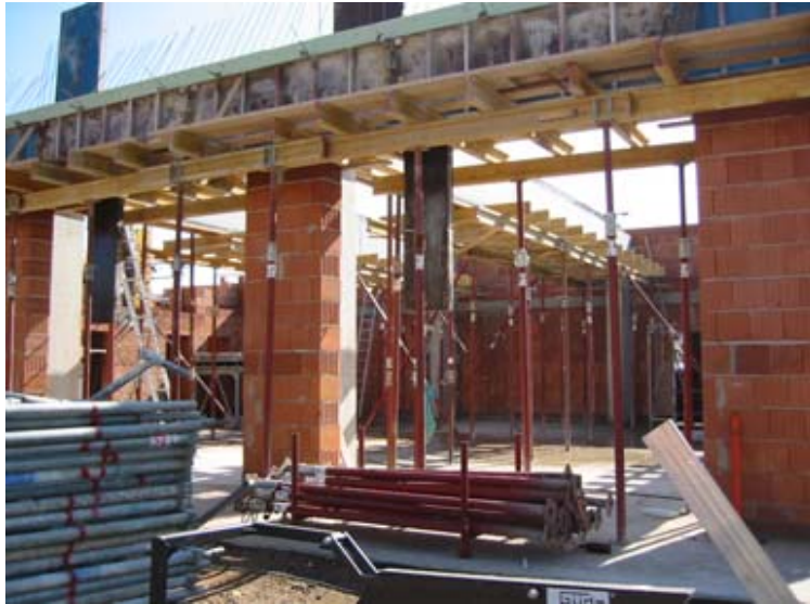
Rohbau, Einschalung der Unterzüge und Toreinfahrten
